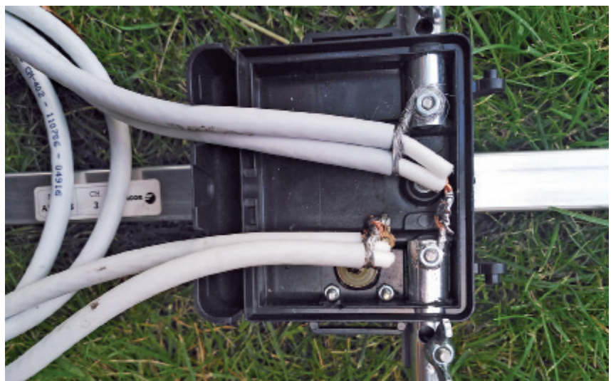
Imagen 4. Intento de usar cable de TV con malla de aluminio
